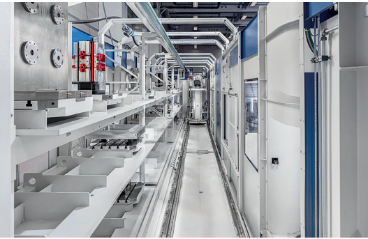
2 Die eigens konstruierten Automationslösungen ermöglichen sowohl teil- als auch vollautomatisches Fertigen © Grob
